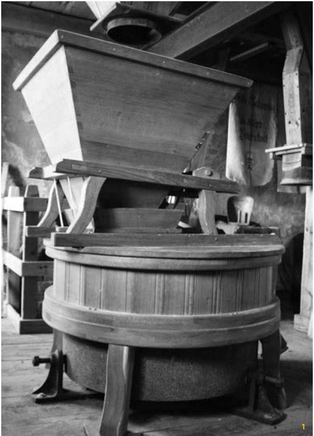
1 Schrotgang der Mühle in Lonnerstadt: Unterhalb der hölzernen Mahlgangabdeckung, der Bütte, liegt der von Wolfgang Strakosch hergestellte Bodenstein aus Basalt. (Foto: Paul Bruckmann)
